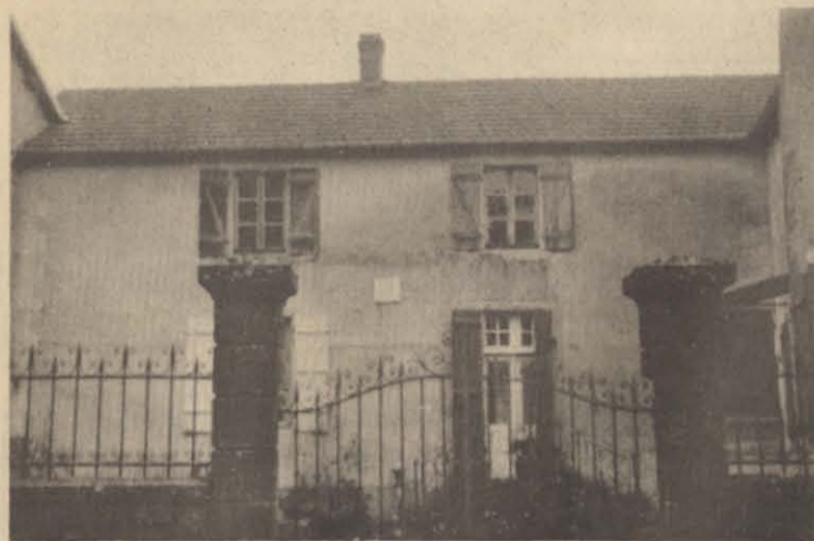
Maison natale de Charles Dadant à Vaux-sous-Aubigny.
