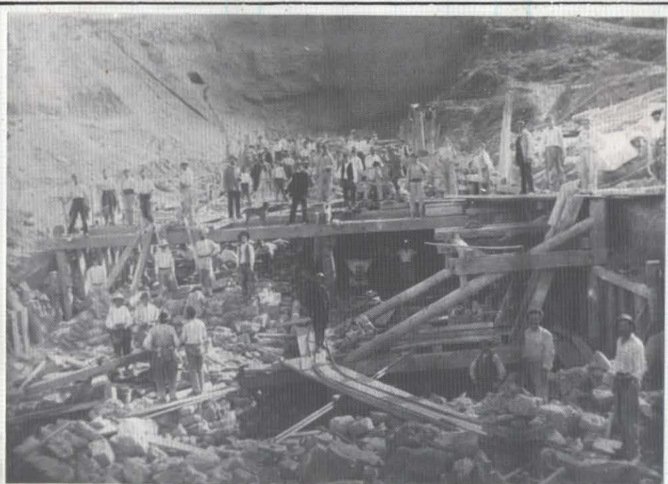
Pendant la construction du barrage.
