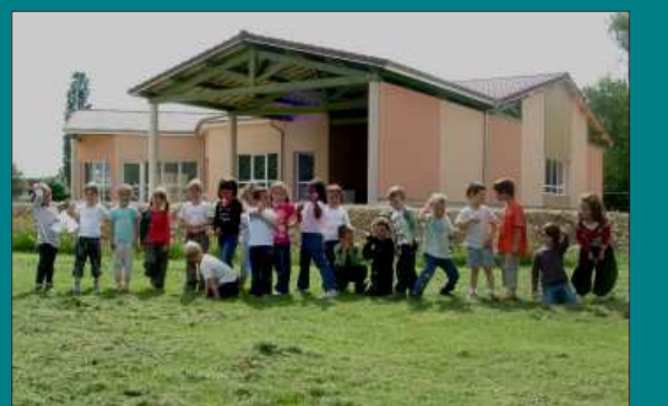
Classe de GS devant la nouvelle école de Longeau en cours de construction (2008)
