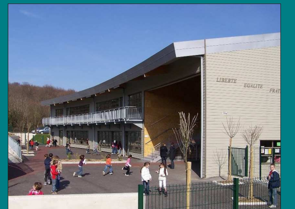
La nouvelle école de Prauthoy N°90
