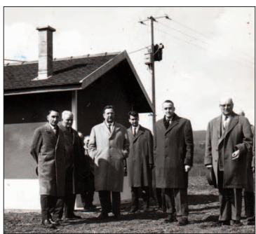
Inauguration de la station de pompage.
