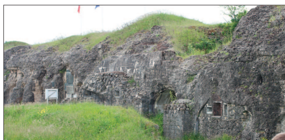
Vue générale du fort de Douaumont.
