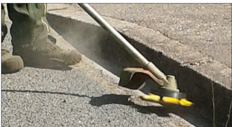
Brosse rotative pour désherber les fils d'eau le long des caniveaux.
