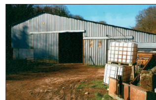
Le hangar de la Comotte
