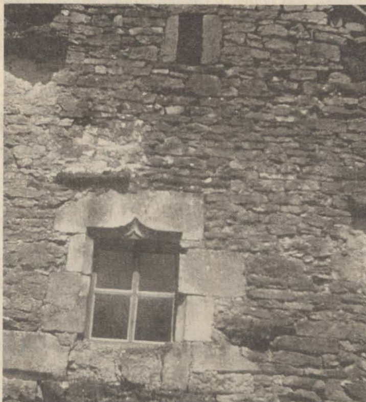
Extérieur paysan appartenant à F. Aubertot construit avant 1750.
