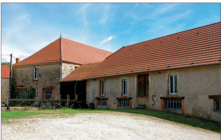
Domaine de Melville (commune de St-Martin-lès-Langres), état actuel d'une partie des dépendances du château.
