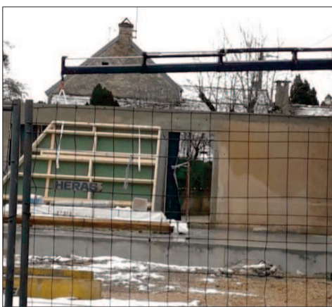
Un jour, un camion est venu livrer la charpente et les cloisons.
