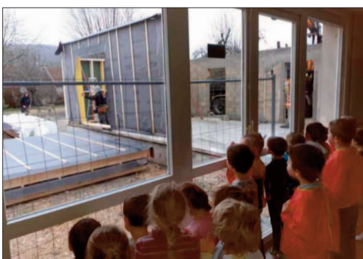
Les ouvriers ont mis les cloisons en bois à leur place sur le petit mur en béton.
