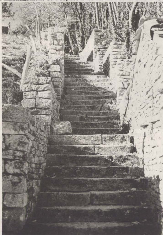
Les escaliers restaurés.
