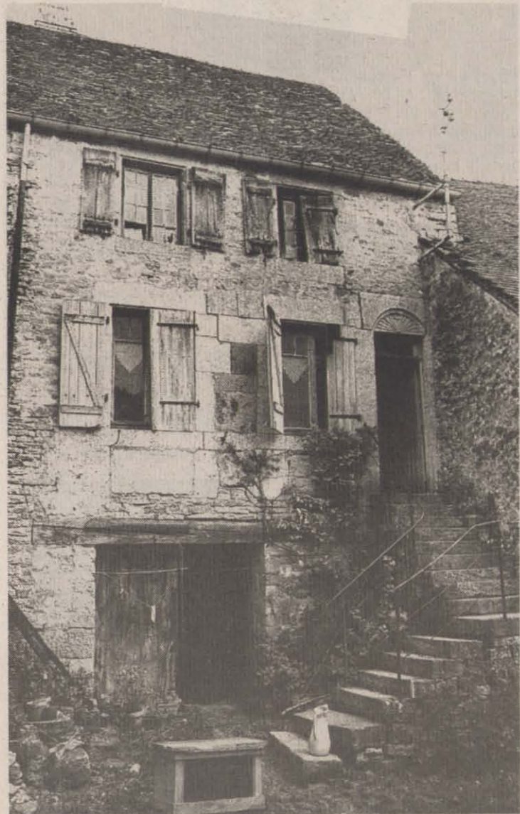
Maison de Pays à Flagey avant travaux.
