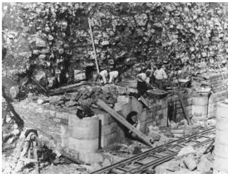
Construction d'une écluse pour le canal
