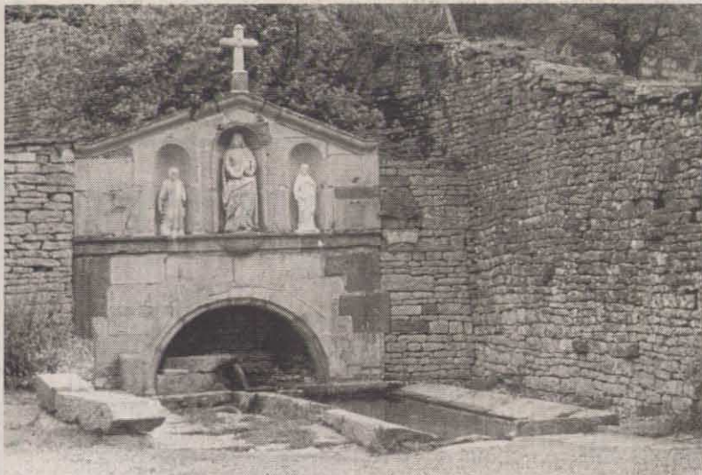
La fontaine Sainte-Marie avant la restauration
