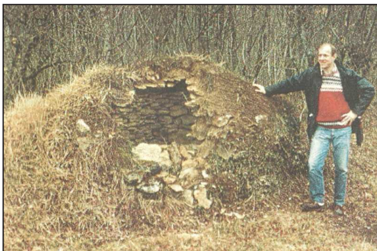
Alain Catherinet près d'un abri de cantonnier, près de la ferme de la Tuillière (commune de Praslay)
