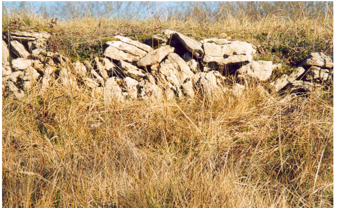
Epierrage ancien en bordure de fliche
