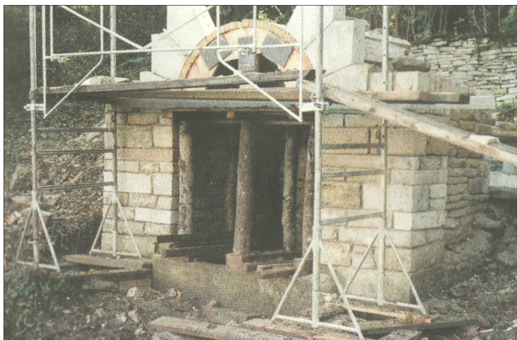
Assemblage de la voûte
