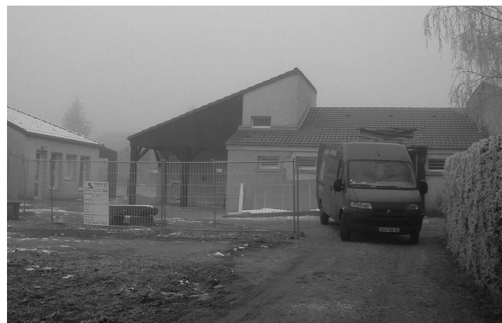
Les travaux se poursuivent près du groupe scolaire de Longeau. Céline Beck, animatrice éducatrice à La Montagne accueillera bientôt les enfants dans de nouveaux espaces au sein d'un bâtiment rénové, consacré à l'accueil périscolaire.
