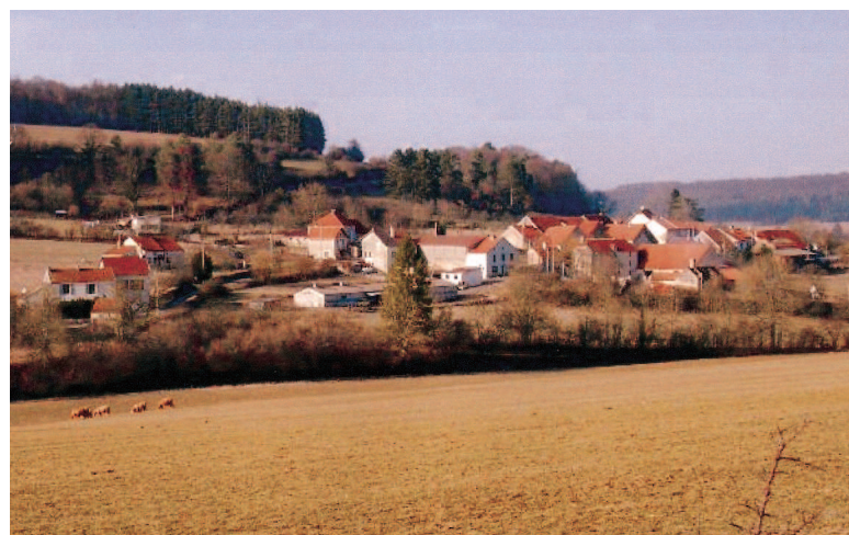
Eriseul - vue générale sur le village
