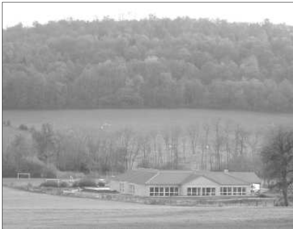
Vue sur la nouvelle construction de l’école Joseph Cressot
