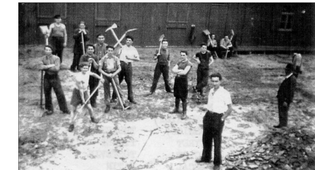
Travailleurs à la construction du nouveau camp de Pasewalker Chaussee
