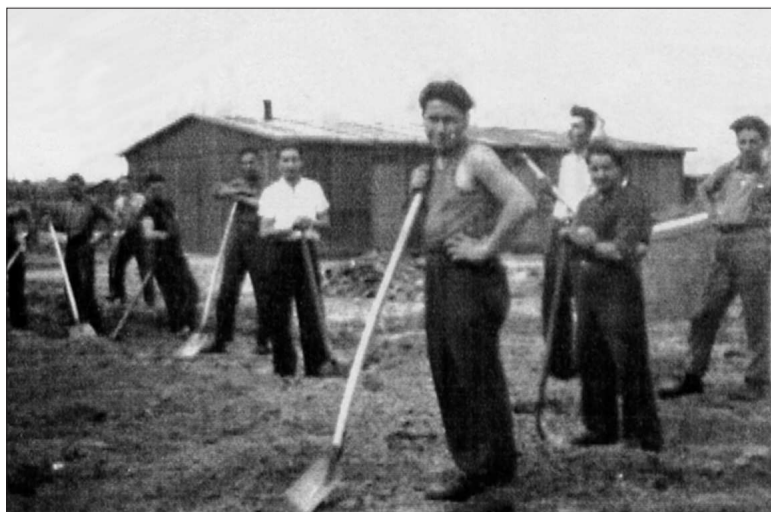
Travailleurs à la construction du nouveau camp de Pasewalker Chaussee
