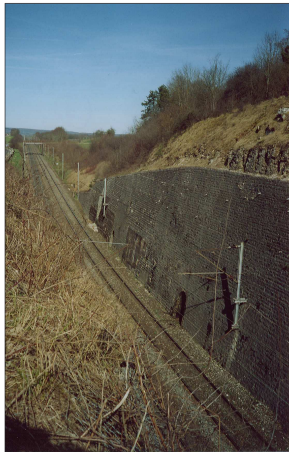
La voie ferrée à Suxy
