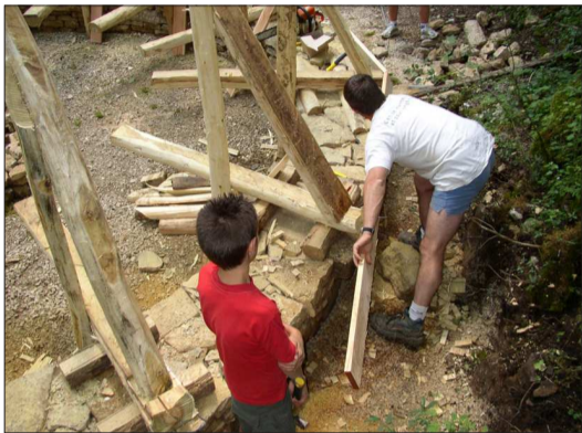
Construire le soubassement
