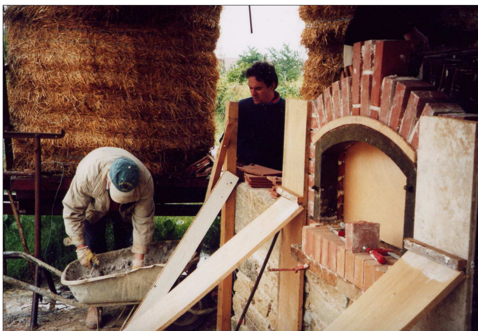
Le four en construction
