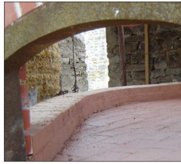
Des bénévoles du village, aidés de Mr Ricordeau (artisan de France) ont posé sur le socle de pierres, des briques réfractaires, c'est à dire qui gardent la chaleur, sur lesquelles le pain sera cuit.
