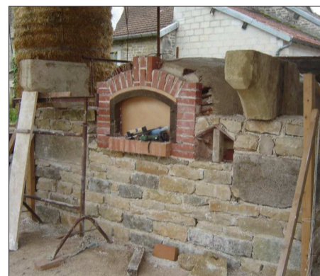
Ensuite, ils ont posé les pierres qui vont soutenir la cheminée.
