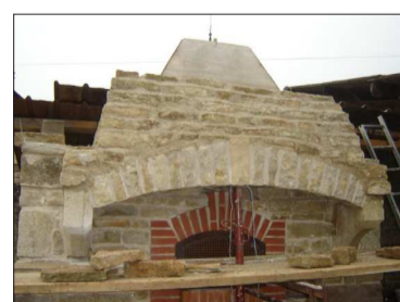
Aujourd'hui, il ne reste plus que le toit à monter. Mais pour déguster du bon pain, il faudra être patient encore quelques mois car Gilbert nous a dit qu'il fallait 6 mois de séchage pour les matériaux et 6 mois de mise en chauffe du four.
