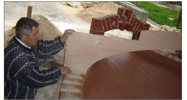
Sur les briques, ils ont formé un tas de sable qui représente le volume intérieur du four. Mr Ricordeau utilise un gabarit pour donner la bonne forme.
