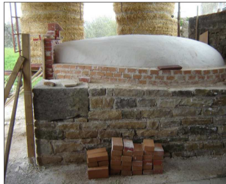
Puis le sable est recouvert de plâtre ce qui forme la coquille.
