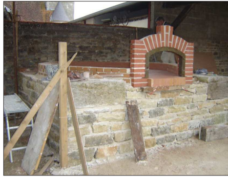
Des bénévoles du village, aidés de Mr Ricordeau (artisan de France) ont posé sur le socle de pierres, des briques réfractaires, c'est à dire qui gardent la chaleur, sur lesquelles le pain sera cuit.
