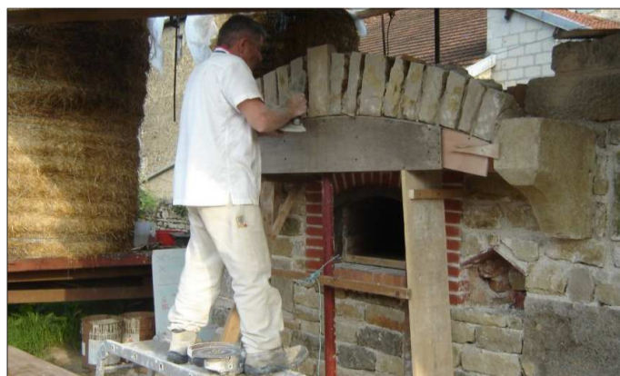
Sur les deux grosses pierres, Gilbert a installé la voûte de la cheminée.
