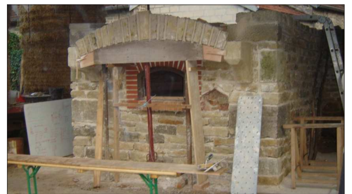
Sur les deux grosses pierres, Gilbert a installé la voûte de la cheminée.
