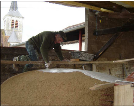
Puis le sable est recouvert de plâtre ce qui forme la coquille.
