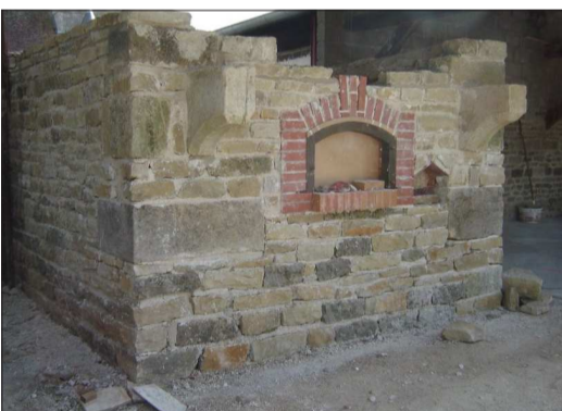
Ils ont continué le mur en pierre qui dépasse les tuiles recouvertes d'enduit.
