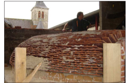
Sur la coquille, ils ont posé les tuiles en rond. Ils ont fait tenir les tuiles avec de l'enduit. Ils ont recouvert le dôme de tuiles pour former un hériss.
