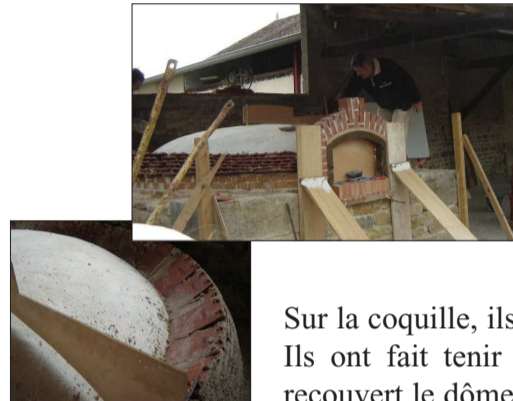
Des bénévoles du village, aidés de Mr Ricordeau (artisan de France) ont posé sur le socle de pierres, des briques réfractaires, c'est à dire qui gardent la chaleur, sur lesquelles le pain sera cuit.
