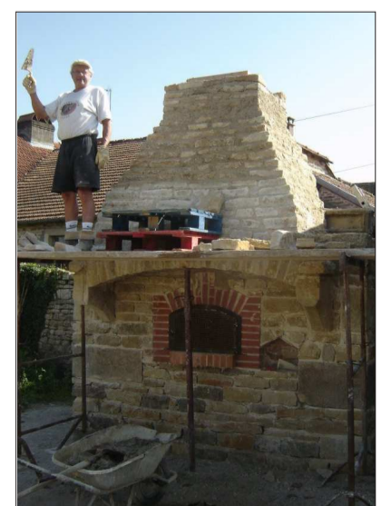
Aujourd'hui, il ne reste plus que le toit à monter. Mais pour déguster du bon pain, il faudra être patient encore quelques mois car Gilbert nous a dit qu'il fallait 6 mois de séchage pour les matériaux et 6 mois de mise en chauffe du four.
