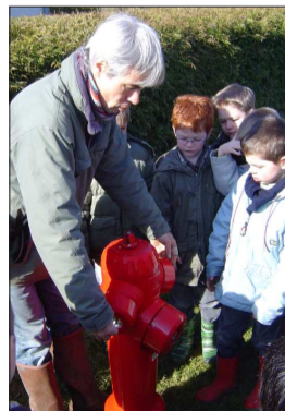
Une borne à incendie
