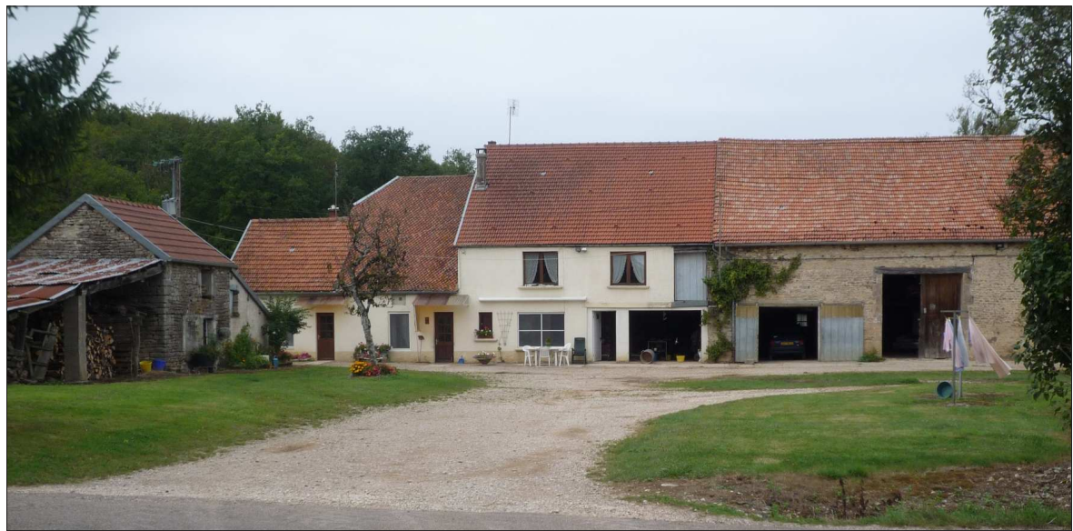
Ferme de Servin (état actuel).
