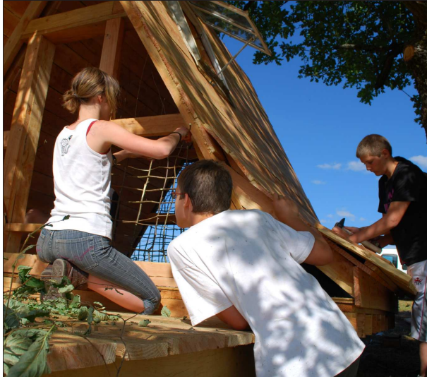
Montage des clisses en viorne pour soutenir le torchis
