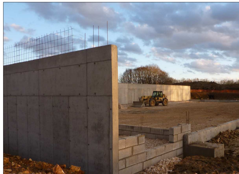
Construction de la halle de la santé et de la forme
